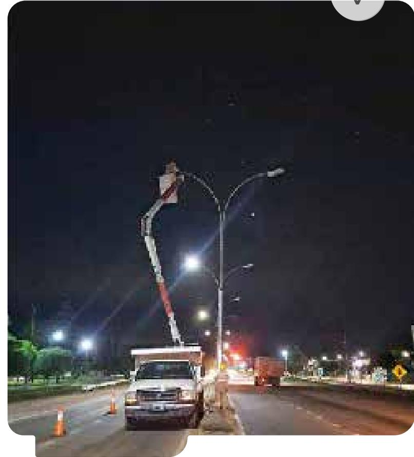
Reemplazamos 50 luminarias de sodio por LED en la Ruta 9, completando el tramo con iluminación eficiente.
